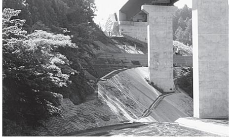
本線区間の大規模な盛土工事がメインで、このほか切土、地盤改良、調整池等の工事を担当している。盛土工事は、他の現場で発生する土砂を受け入れる際に、搬入、締め固め作業を数カ所で行っていたほか、大和田第一橋の上部工事と同じエリア内で展開されていたことなどから、土砂の運搬管理、大型重機の安全管理に細心の注意を払い、運搬車両と重機の事故防止に努めた。また盛土だけでなく、途中、排水構造物の築造が入る作業工程では、両工事が円滑に安全に進むよう、調整に慎重に対応した。盛土では土砂の含水率が工期と品質を左右するため、本年1月の降雪では除雪作業を実施し作業が止まらないよう工夫し、作業ヤードが狭く厳しい作業条件の中でも工期を確保した。工事最終仕上げ段階に入っており、不入橋の橋脚廻りの切盛土、道路の機能補償工事を行っている。
