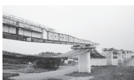
全長835m(橋脚12本、うち河川区域内が10本)の利根川高架橋上部工事を担当。月に1回(計7回)、組立てた橋桁を河川上に約120m送出す作業があるが、今日は偶然にも、第2回目送出し架設の日にあたる。全ての作業が高さ15mの高所のため、墜落事故や落下防止ネット、資材の飛散防止に努め、作業員にはハネス型の2丁掛安全帯を使用させる指導を徹底。強風対策としては、防風灯が点いたり、ブザーが鳴るデジタル風速計を設置して作業の中止を判断する。クレーン車も強風になると折れたらんで低くし安全対策を講じている。作業現場をきれいに整理し、片付けると安全につながる。当たり前のことをやることで事故防止に直結する」と確信。朝礼では全員集めて危険予知活動やその日の作業手順を確認しながら現場に入る。
